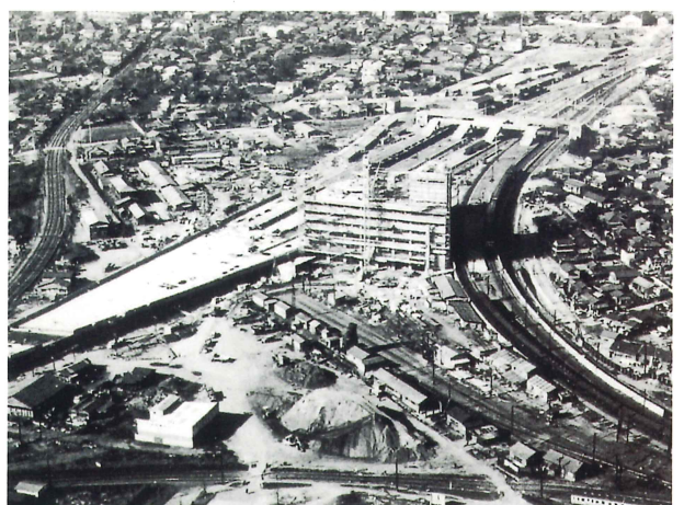
写真3. 移転工事中の千葉駅
