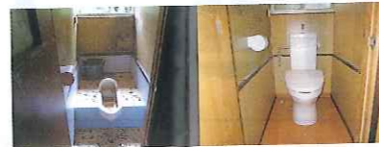
施工前 ▶ 施工後
