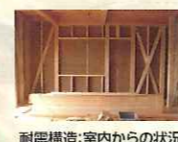
耐震構造:室内からの状況
