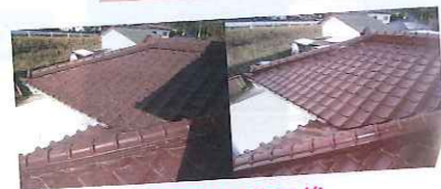
施工前 ▶ 施工後
