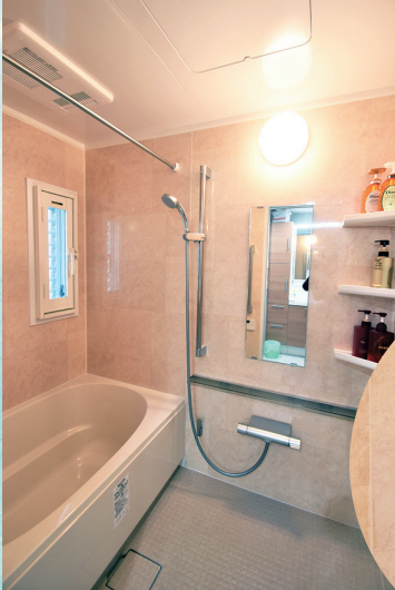
冬場の寒さ対策として 浴室の窓に内窓を設置！
