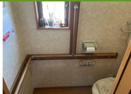
■トイレの手すり
