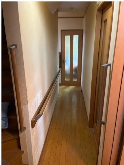
■廊下の手すり
