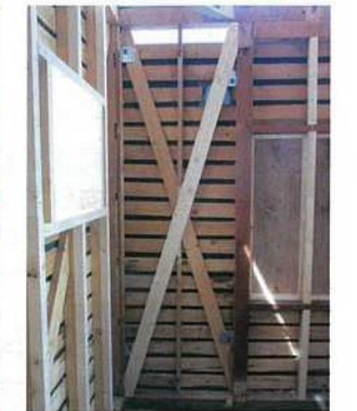
1階の東南角付近の耐力壁は、筋交いをたすき掛けにして耐震性を高めた。
