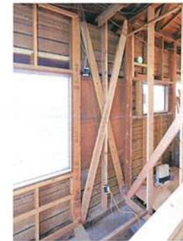
■ 筋かいを入れて補強する
