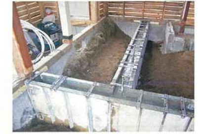
■ 基礎を新設する
