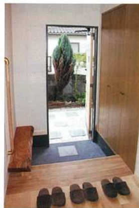
■玄関の段差軽減
