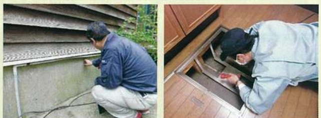
基礎調査 土台・床組・基礎調査
