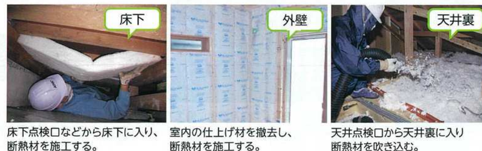
■床・壁・天井の断熱改修例
