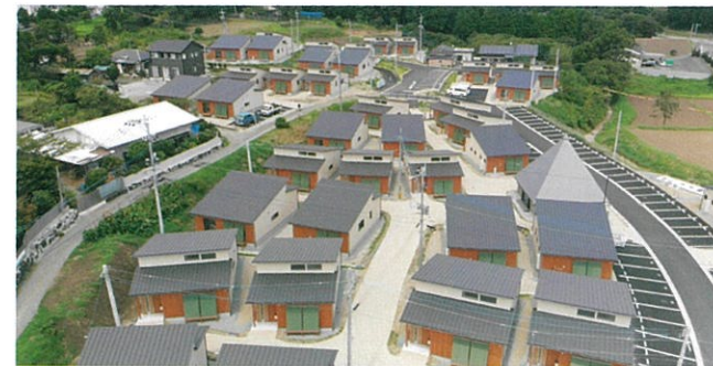
西原村の災害公営住宅の様子
